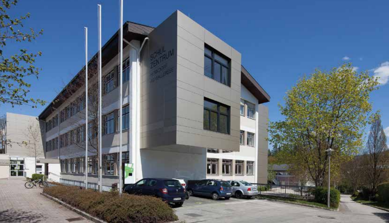
Das Schulzentrum in Henndorf wurde umfangreich saniert- und umgebaut.
