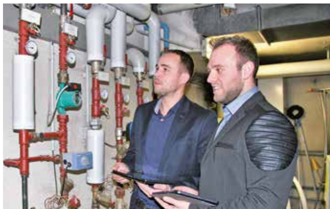
Auch die Zustandsbeurteilung eines Heizverteilers liefert wichtige Erhebungsdaten für die epiqr®-Datenbank. Bilder: KommunalService / kmh
