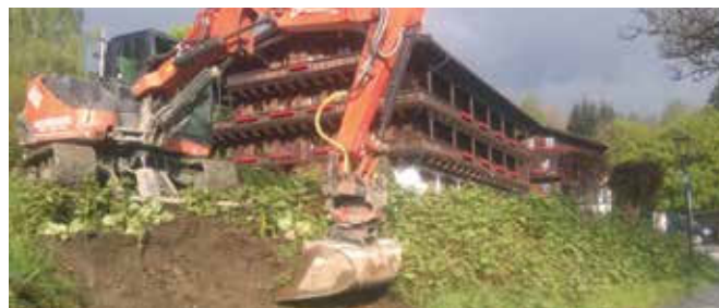
Mit der fachlichen Koordination der Arbeiten – wie hier im Bild zwischen Seeweg und Parkplatz Hotel Post – wurde der Maschinenring beauftragt.
