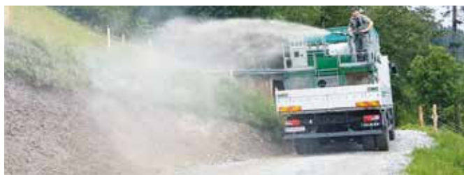
Hier für den Kunden INFRA-Bau nach einem Wegebau im Bereich des Brandalmwegs in St. Johann. Ausgeführt wurden die Arbeiten von Mitarbeitern des Landesforstgartens.
