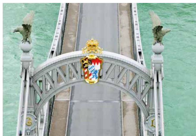
Länderbrücke Laufen/Oberndorf. Bild: Stadt Laufen
