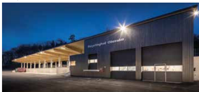
Bau- und Recyclinghof Oberalm
