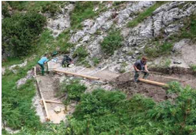
Bau und Sanierung von Wanderwegen. Bilder: Maschinenring
