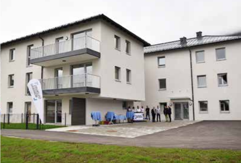
18 geförderte und für Senior:innen geeignete 1- und 2-Zimmer-Mietwohnungen wurden in Mauterndorf errichtet.
