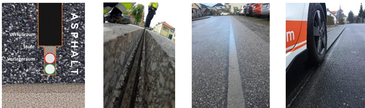
Abbildung 2 grafische Darstellung und Bilder des Stufenschlitzgrabens
